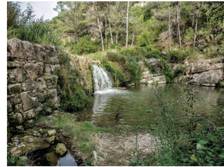
Reclosa de Santa Perpètua de Gaià. Pontils. Alt Gaià.
