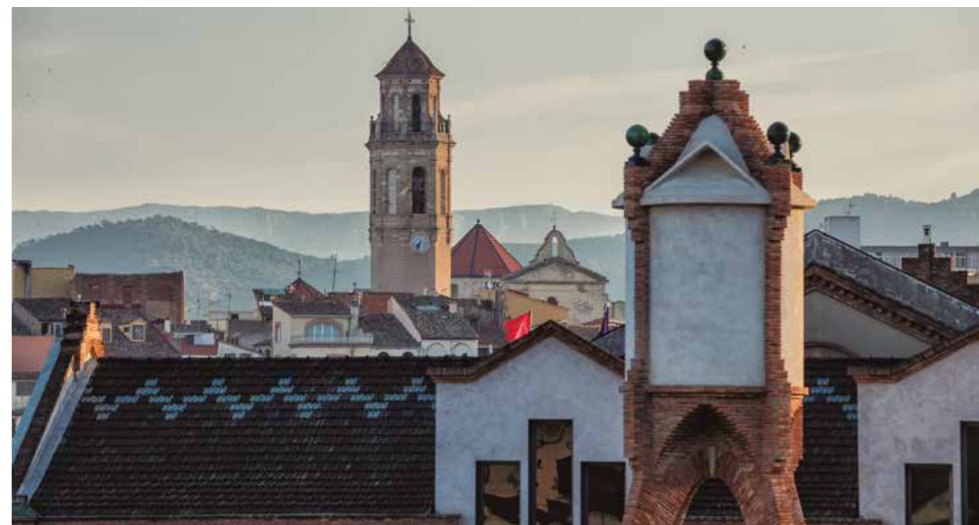
Cèsar Martinell Brunet. Dipòsits o torres de l'aigua del celler de Gandesa (1920); celler de Barberà de la Conca (1920-21); celler de Falset (1919)
